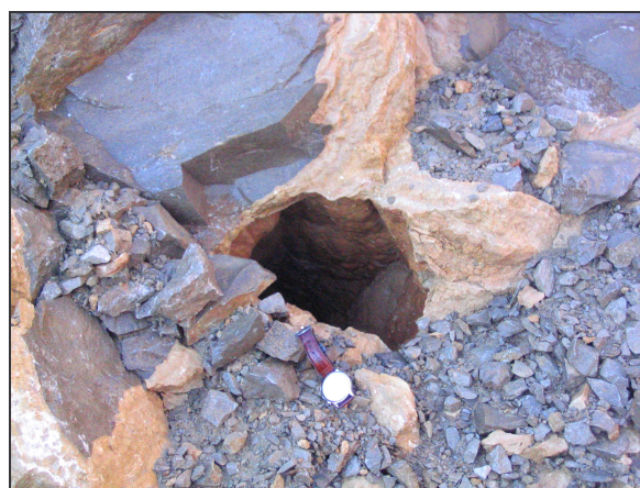
Figure 3 : Situation du point d'injection et cavité découverte lors de la réalisation de la fosse.
