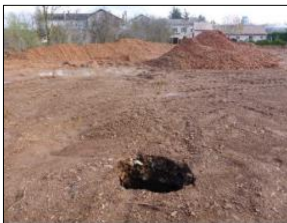
Figure 15 : Photographie du fontis apparu au nord du projet (source : SEQUABAT)
