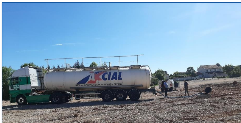
Injection d'eau claire à partir d'un camion-citerne
