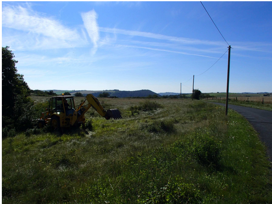
Test d'infiltration le 06/08/2014
