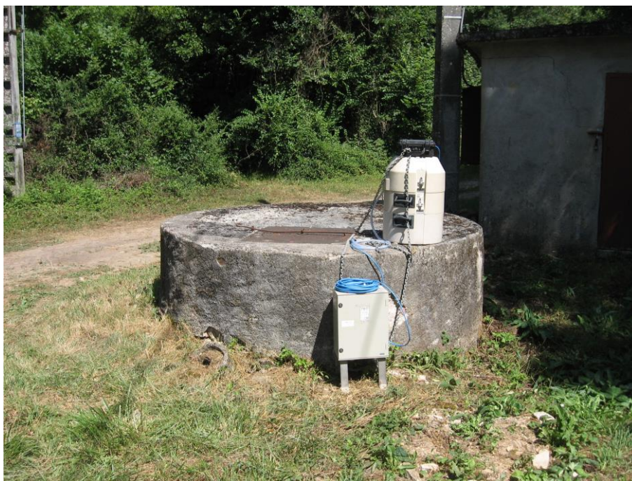
Photo 4 : Préleveur automatique et sonde de niveau dans le puits de Gauty
