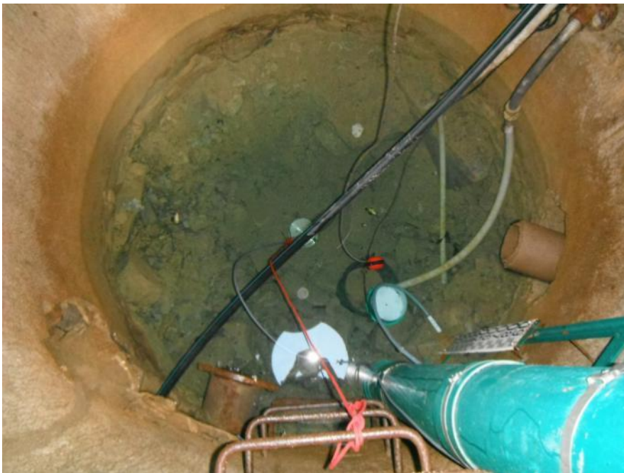
Photo 13 : Vue intérieure du puits du Gauty
