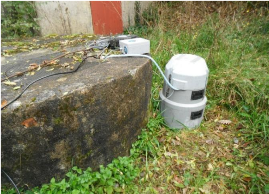
Photo 12 : Préleveur et fluorimètre installés au puits du Gauty
