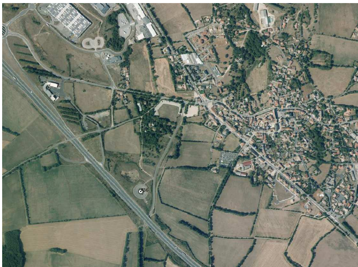
Figure 5 - Vue Aérienne bassin A36
