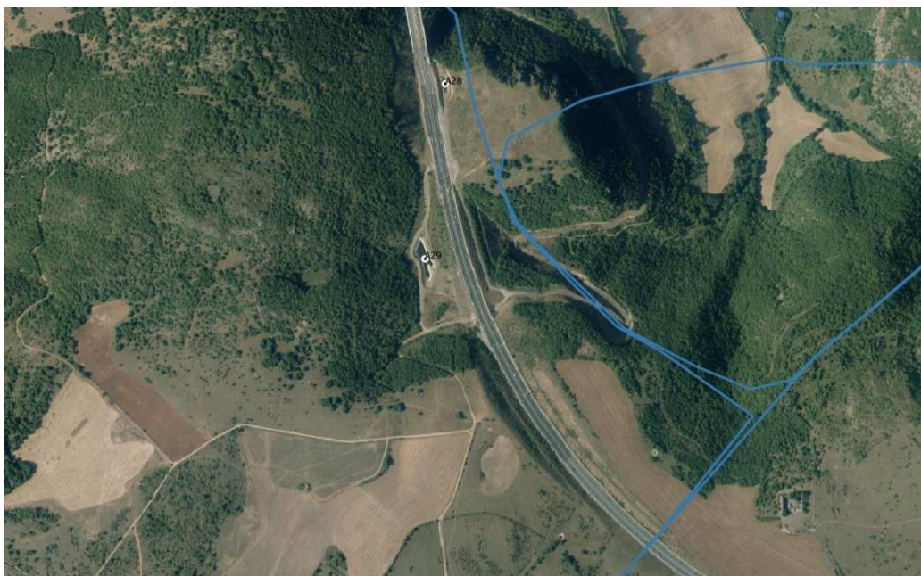
Figure 2- Vue Aérienne bassin A29
